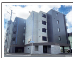
対象物件 外観 (2024年11月撮影 一部修正加工済)
